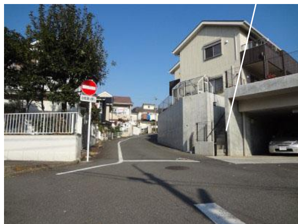
写真 12 上水工事の失敗の伝承“かなしい坂” (写真の左側は谷戸、右側は図 24 中の写真の現在)
