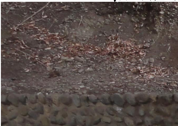
写真2 玉川上水左岸側の段丘礫層
