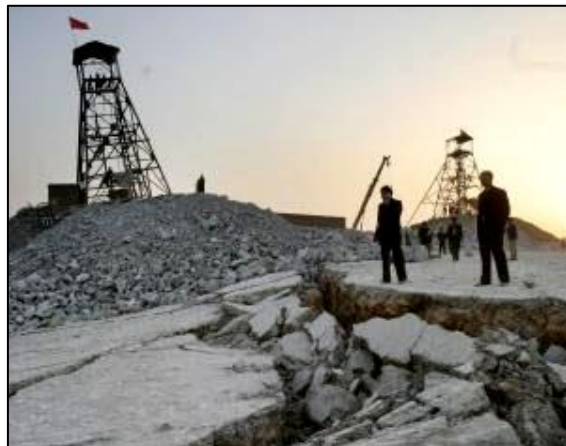
写真 32 邢台县会寧鎮尚汪莊康立石炭 鉱山の崩落事故 (約 1m 幅の地割れが随所にみられる)
