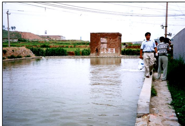
写真 34 排水された坑内水のプール
