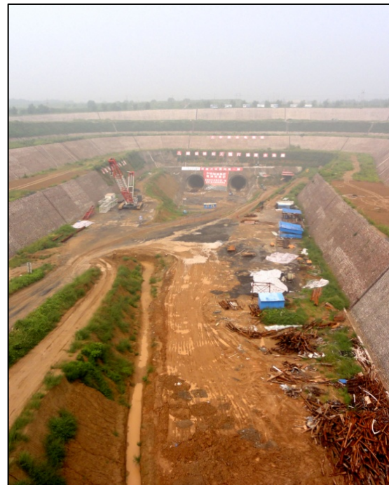
写真16 急ピッチで進む掘削工事 (前方は黄河の堤防、導水口が見える)
