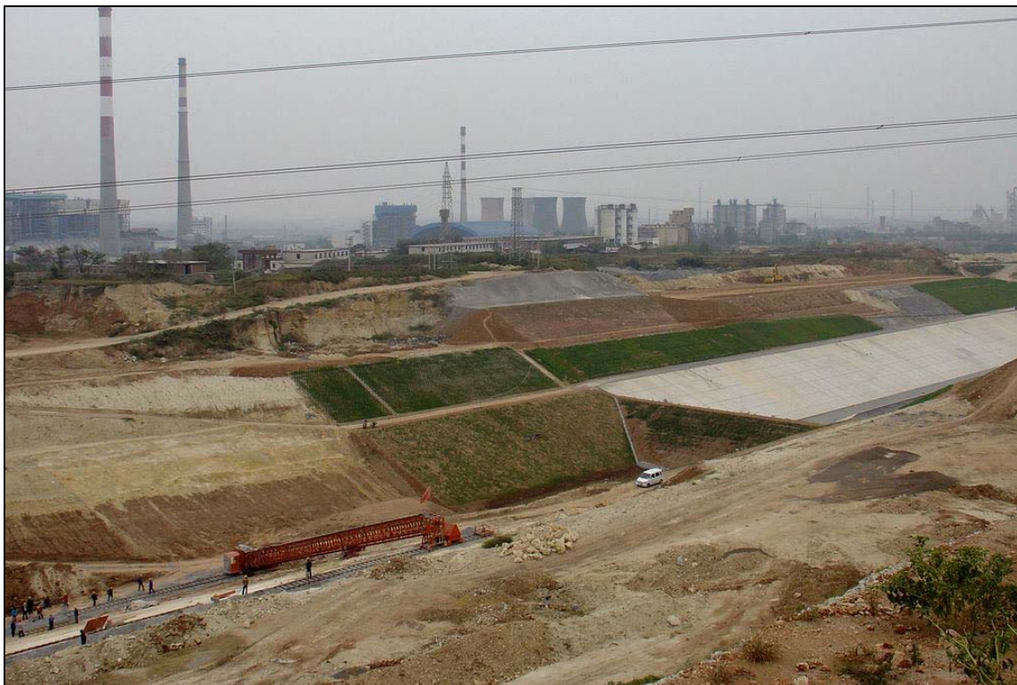
写真 10 黄河の北、潞王墳の南水北調工事現場、泥灰質岩の崩落と修復工事 (出典：Google earth)
