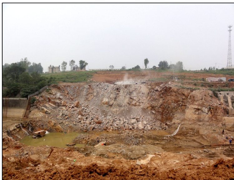
写真 2 頭首工付近の岩盤掘削 (前方は水庫側、発破の白い噴煙が頻繁に立ち昇る)
