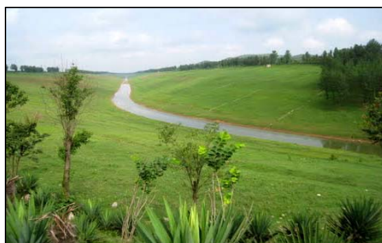
写真9 完成後の渠道
