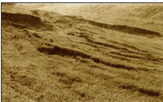
写真7 工事中渠道斜面に発生した滑落②
