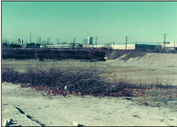
写真 12 造成中の浸透ベースン (Nassau 郡)
