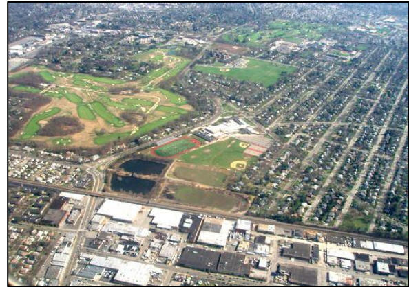
写真 13 浸透ベースンの俯瞰 (Nassau 郡)
