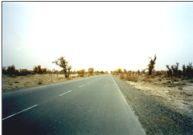
写真19 胡楊林を切り開いて建設されたタリム沙漠公路
