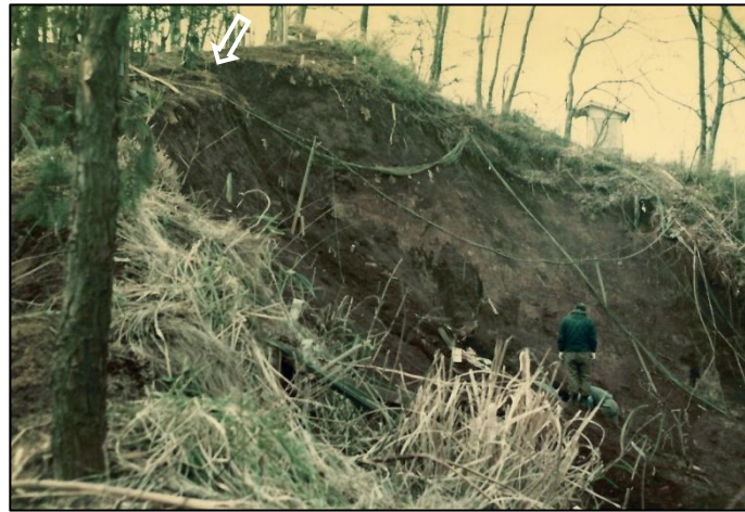
写真3 崩落崖 (ローム層のブロック化が認められる。矢印)
