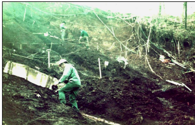
写真4 崩落崖直下の捨土 (公園造成時に投棄され、厚さは最大4mに達した)
