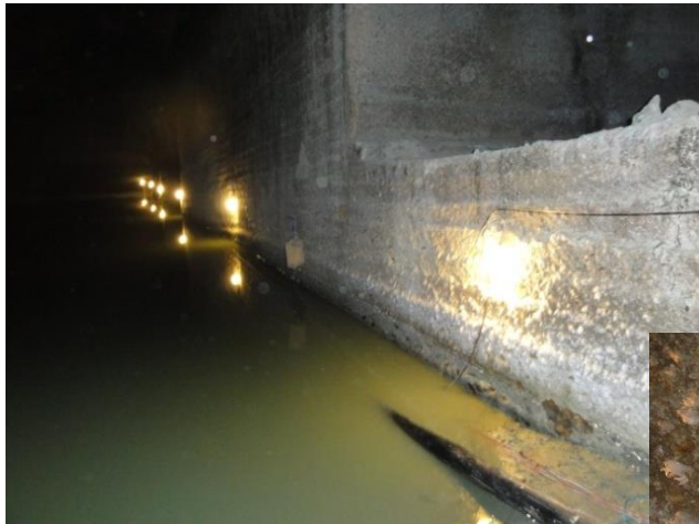
写真 40 同上の近接 〔 沸石の晶出位置は地下水面の位置と関係 〕 〔 図中の矢印は地下水面 〕
