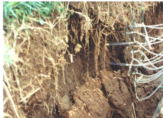
写真 28 同左崩壊発生
