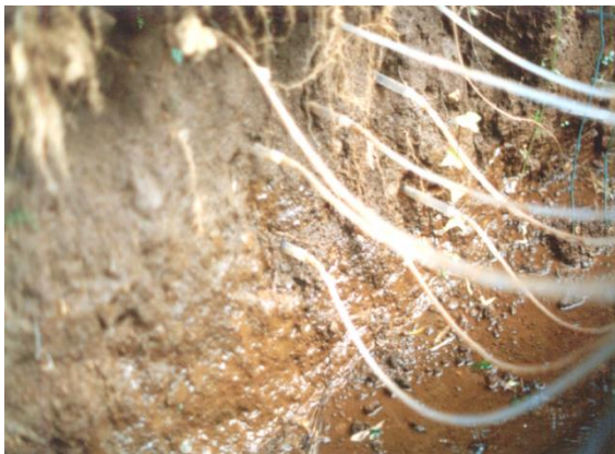
写真 27 降雨時のカッティング底部の水分状態
