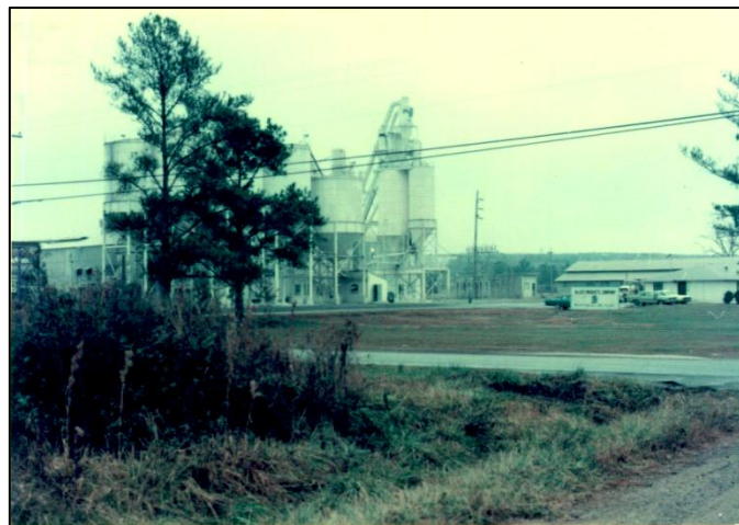
写真 5 遠方の石灰岩採掘現場と手前の陥没孔
