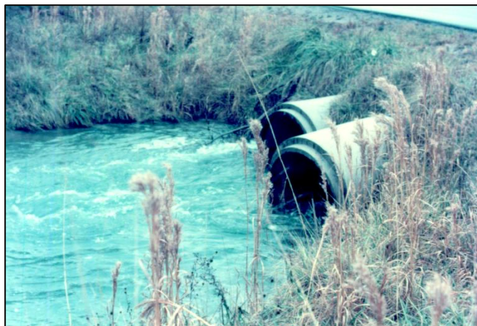
写真 6 鉱内水の排水
