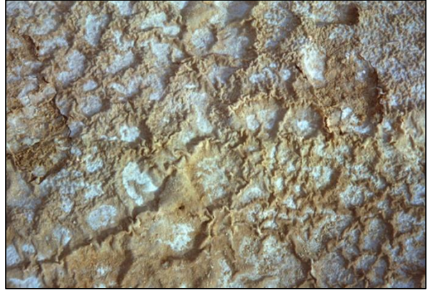
写真 5 同左の近接（塩分の析出）
