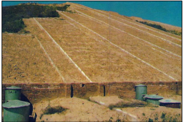
写真 53 最長 50m に及ぶ巨大ライシメータ (陝西省安塞 水土保持総合試験場)
