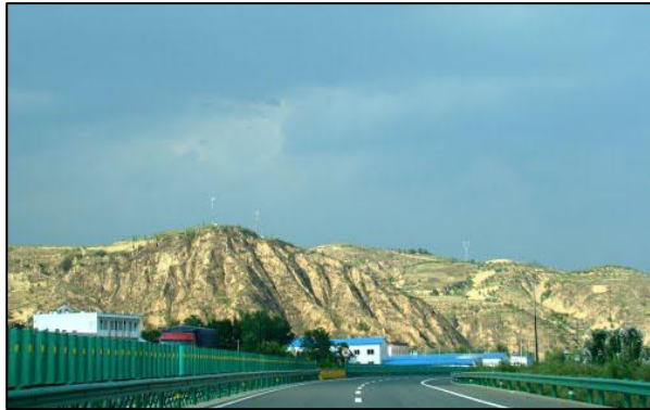
写真 45 黄土高原を貫いて走る高速道路
