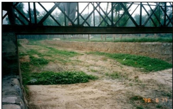
写真 46 輸沙によって天井川化した小河川 (山西省離石、水文観測所)
