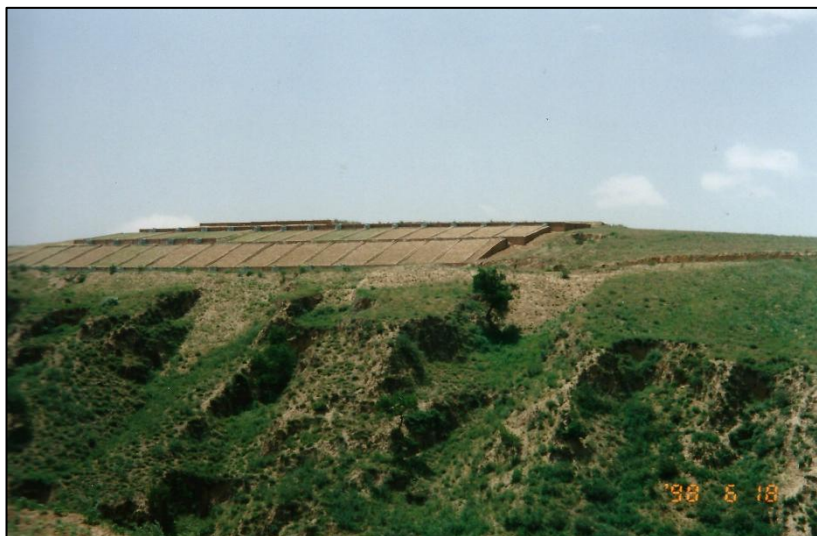
写真 52 稜線直下に設置されたライシメータ群
