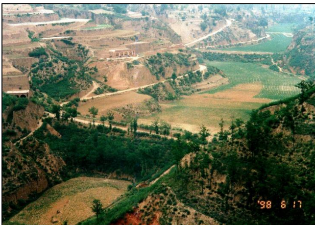
写真50, 51 堰堤によって溝底に堆積した黄土と、それによって造成された農地 (山西省離石 王家沟)
