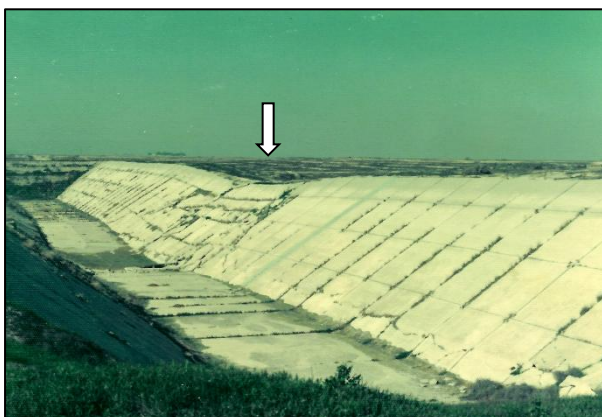
写真 59 試験導水によって発生した地盤沈下
