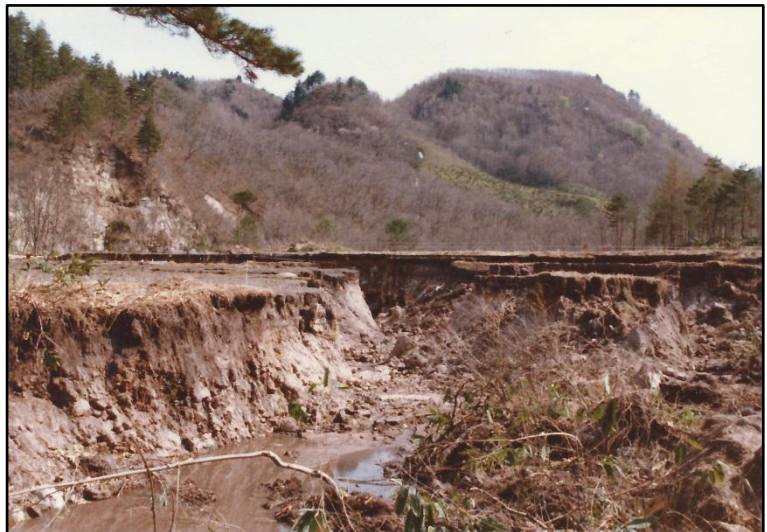
写真 94 地すべり土塊中の地下水
