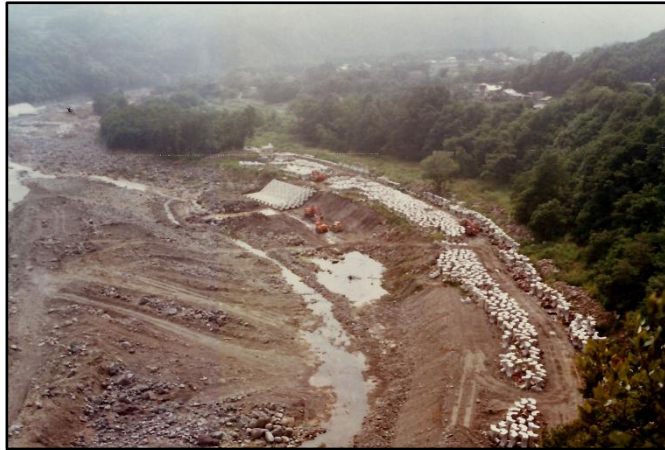
写真 86 押さえ盛り土工事（図 48 の湾曲部）
