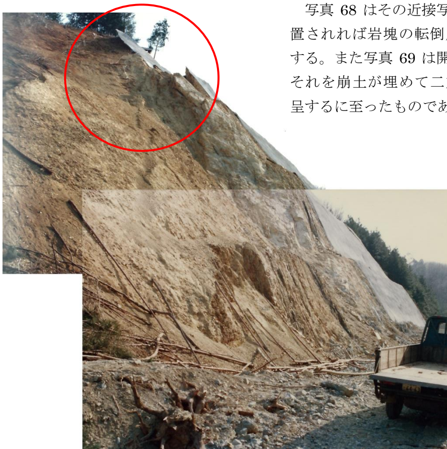
写真 67 峠道の拡張工事によって生じた斜面の変形(○部分) (最終的に一部ロックボルトにより固定して開通した。八王子市美山町)
