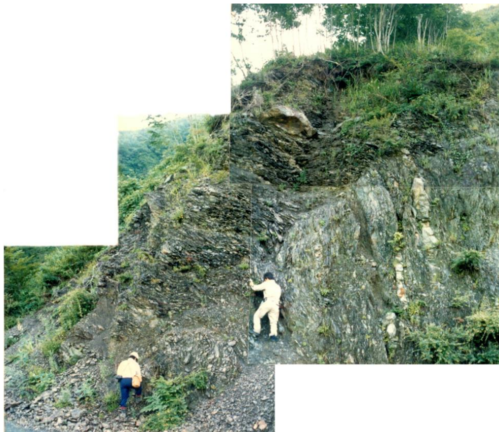
写真 77 極度に進行した岩盤クリープ (基盤岩との境界面から地下水が滲出している)
