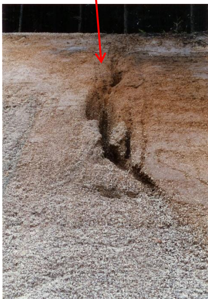
写真 48 埋没谷側壁のガリ浸食
