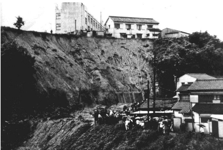
写真 66 シラス台地の崩壊
