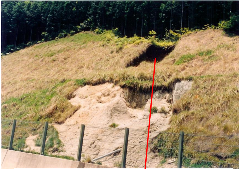
写真 50 埋没谷直下に発生した崩壊 (1991年9月)
