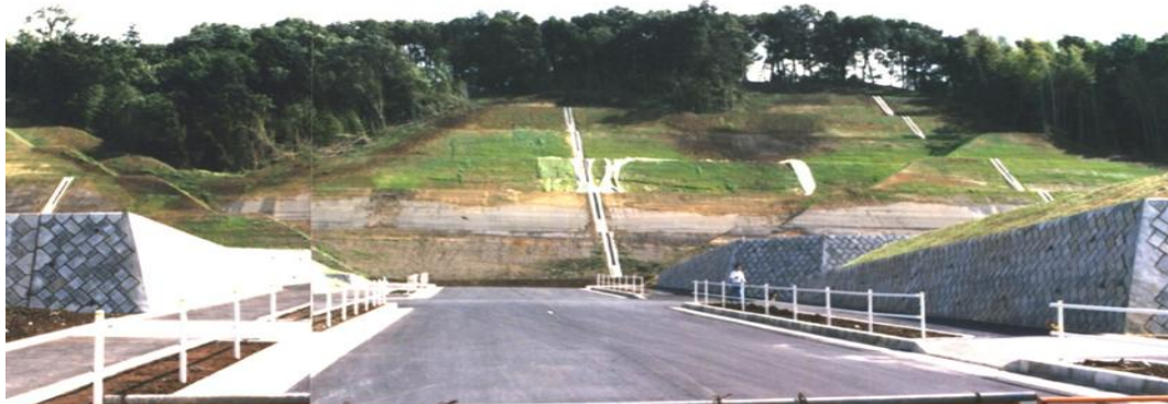
写真 43 切り取り斜面に出現した埋没谷 (矢印)
