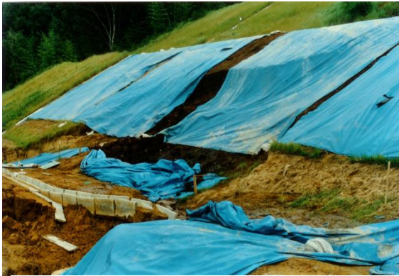
写真 45 埋没谷の 崩壊
