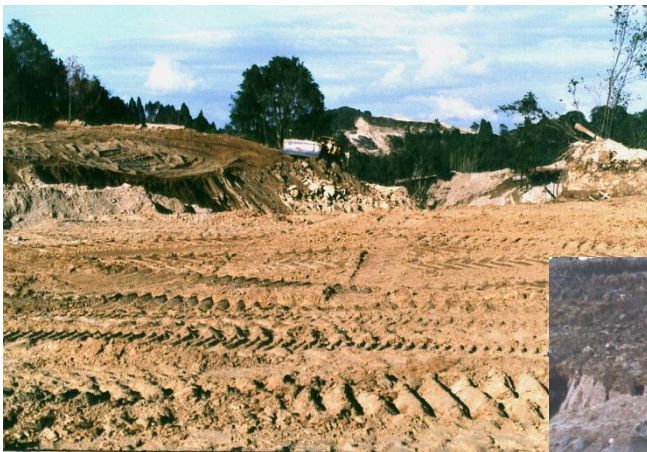
写真 61 ゴルフ場の造成風景 (山は削り取られ、その土砂は谷に埋められた)
