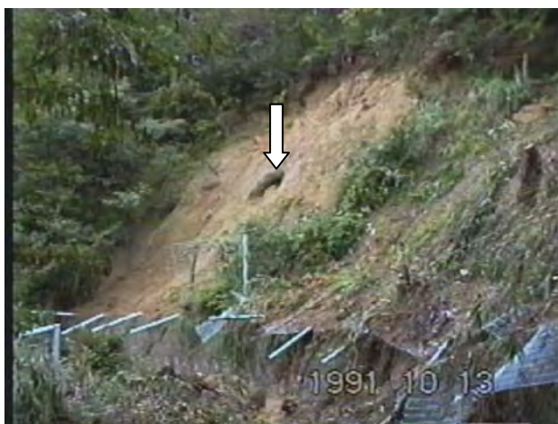
写真 34 崩壊地に出現した巨大パイプ
