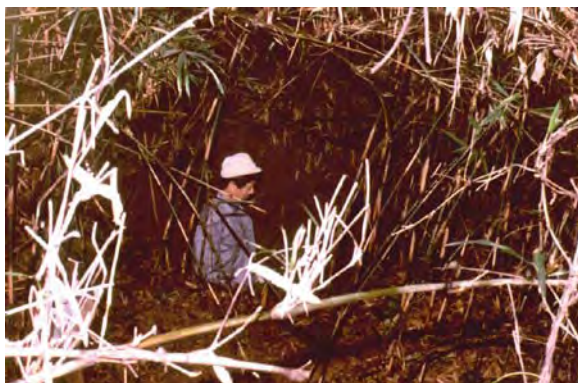
写真 19 多摩丘陵内の谷頭斜面にみる陥没孔 (周りの地層は崩積土)
