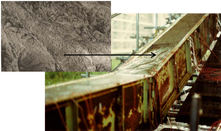
写真2 遷緩部におけるパイピングと崩壊
