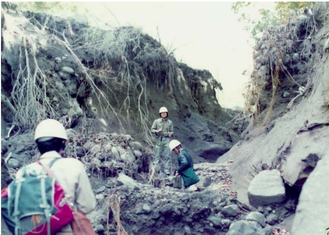
写真 9 吹き飛んだ砂防堰堤
