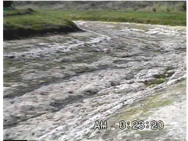
写真 11 水を抜いた後の浸透水路床の沈殿物
