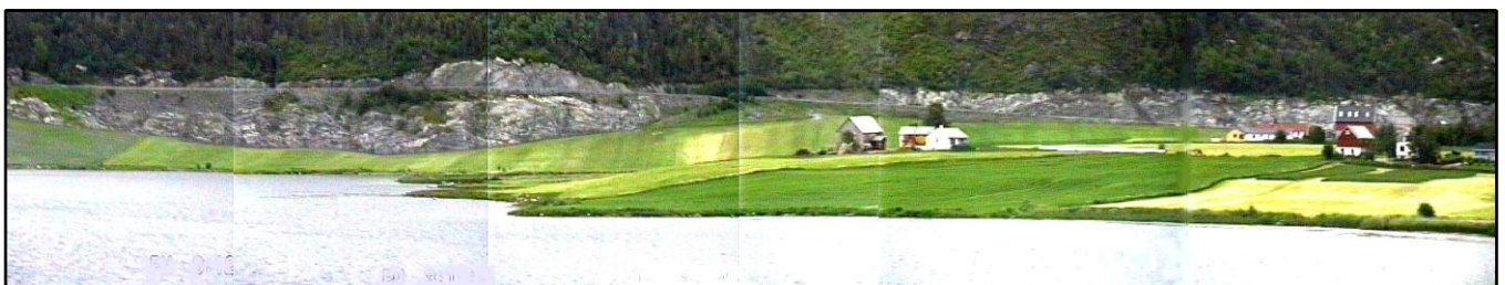
写真 13 対岸から望んだ地じり地
