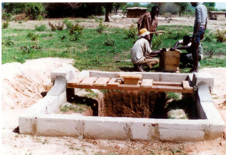
地下水位観測孔の建設 (写真 36)
