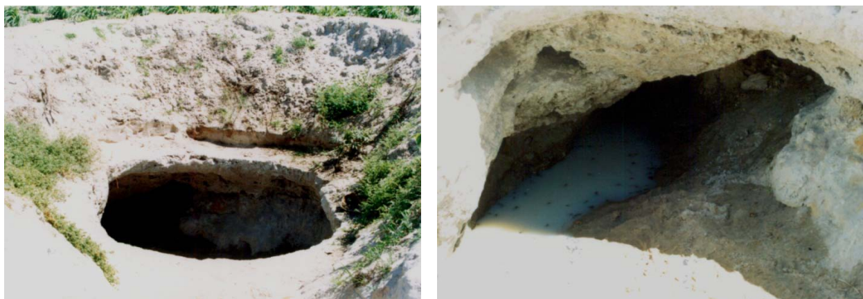
写真 24 シロアリ塚を削り貫いて造られた貯水槽
