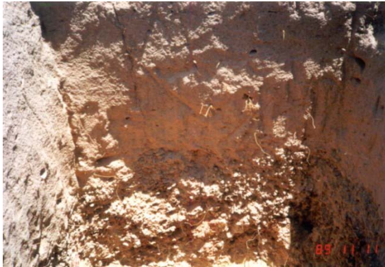
写真 11 シロアリ塚の掘削記録 (1)
