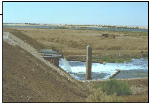
写真 19 リーチング水の排水口
