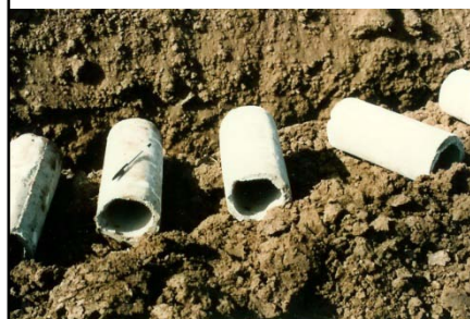
写真 21 リーチングパイプの設置 (ダフラオアシス)
