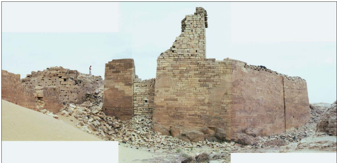
図 15 左岸側の水門塔
