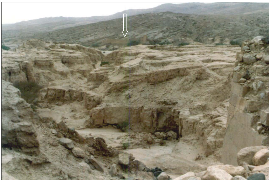
写真 26 ダムの堆砂 (矢印は右岸側の水門)
