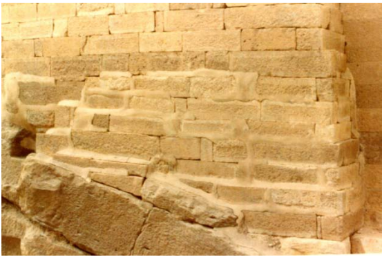
写真19 石灰岩ブロックの隙間を埋める漆喰
