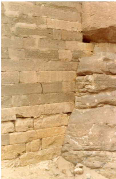
写真21 岩盤とブロックの接触部
