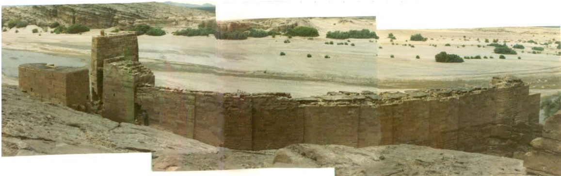
写真14 右岸側の水門塔
