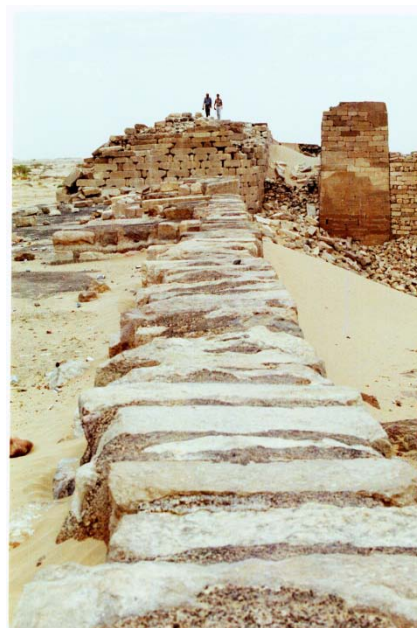
写真22 左岸側の擁壁
