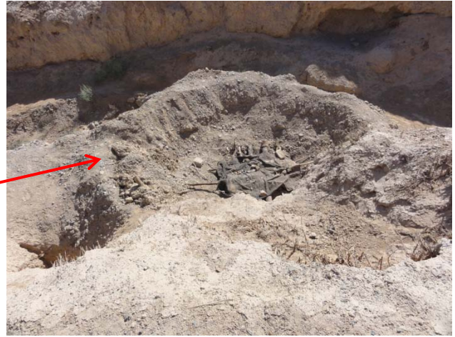
写真 11 谷筋の脇に掘られたカレズの豎孔①
