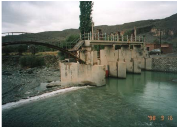
写真16 大規模な頭首工
