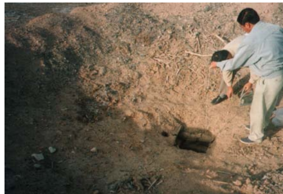
写真 15 カレーズ立坑の坑口
