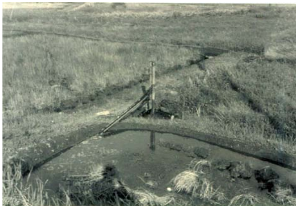
写真 1 上総堀りによって掘られた灌漑用の井戸 ともに昭和 30 年代の風景
