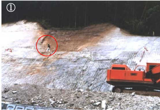
① 工事によって出現した埋没谷（左上の人間と比較）
