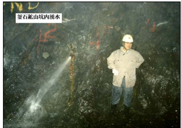
写真 21 250m レベル坑道の湧水状況
