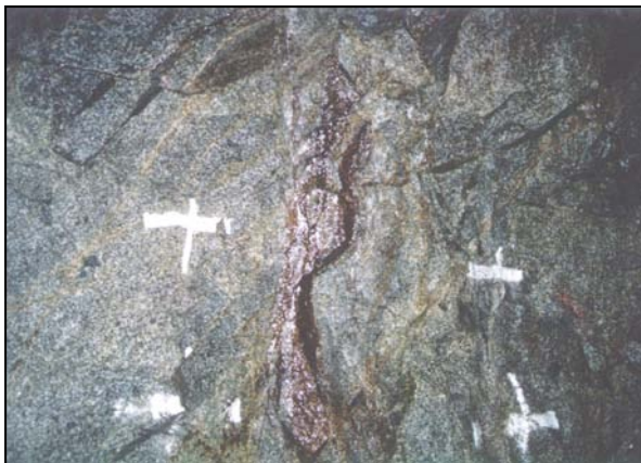
写真 20 550m レベル坑道の湧水状況
