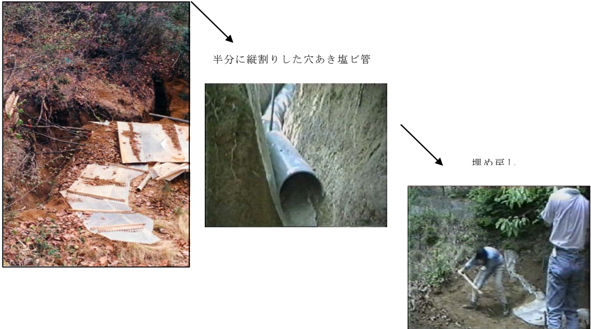
写真 17 森林伐採後のトレンチの増掘と集水管の設置・埋設
